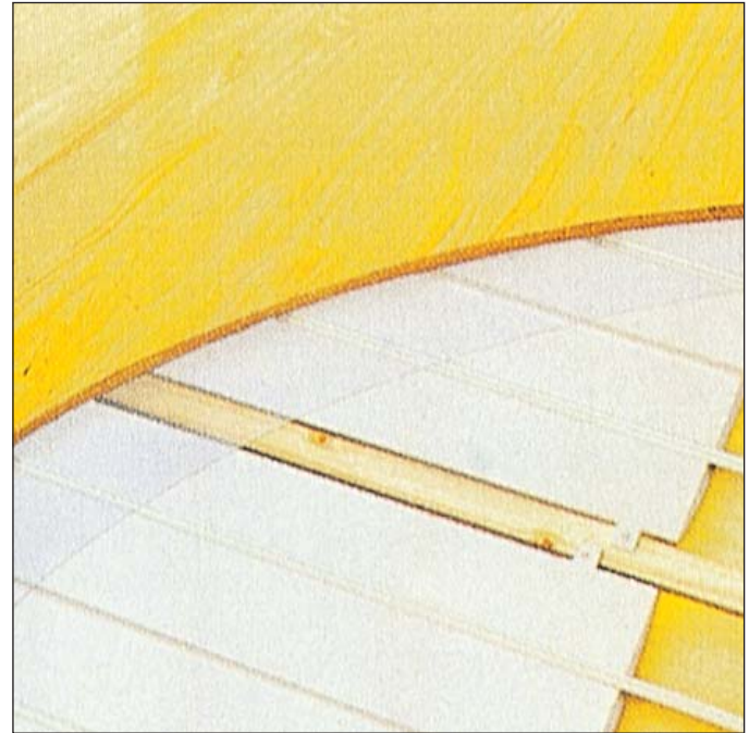
Er underlaget trebjelker legges rørene i gulvvarmekassetter som spikres fast i bjelkene.
